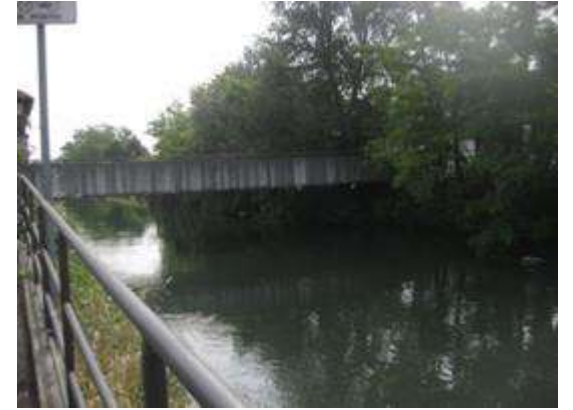
Ponte ciclo/pedonale a Gorgonzola (Fonte: personale)
