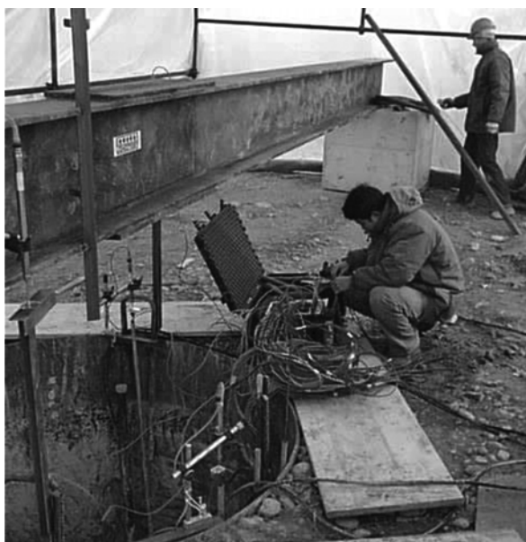
Fig. 9 – Le apparecchiature visibili in cantiere durante la prova Osterberg.
